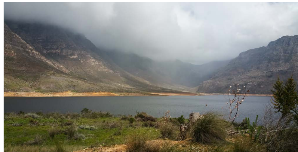
Berg River Dam
