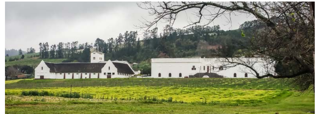
Nietvoorbij ARC Buildings
